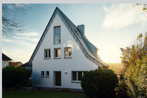
Dachausbau, Umbau und Sanierung
