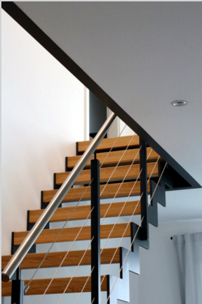
Umbau und Renovierung Einfamilienhaus
