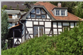
Umbau historisches Wohnhaus
