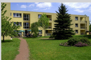
Anbau Altenpflegeheim Bad Münstereifel
