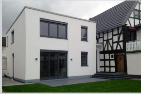
Erweiterungsneubau mit Teilsanierung
