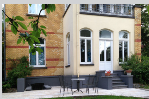
Treppenanlage und Terrasse
